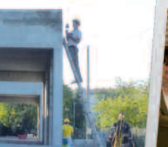
Travaux école du Planty
